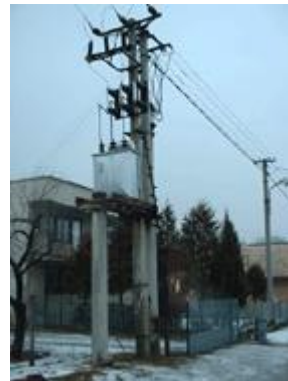
▲ Stĺp s elektrickým vedením a trafom
